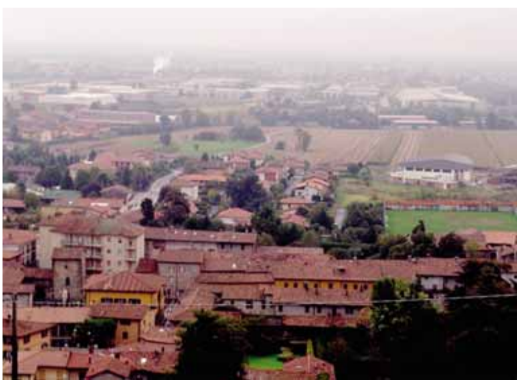
Veduta della zona industriale di Mapello
