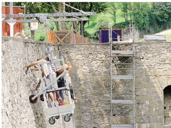
La piattaforma per la pulizia delle Mura che è bloccata per la burocrazia
